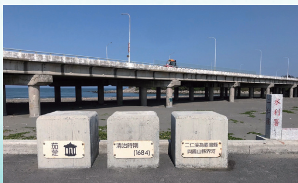
▲台 17 線二仁溪橋出海口河堤 / 攝影：蔡達智 / 2024.03.03
